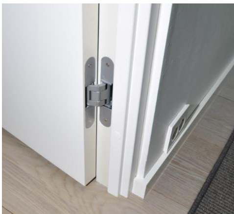
Detalj av monteringen. Her er det brukt gipshjørne. Gulvlisten er gjæret og avsluttes inn mot karmen. Hengsle Tectus 340 3D. Denne døren er malt med ulike hvitnyanser på hver side.
